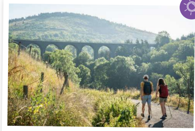
Le viaduc de la Recoumène
